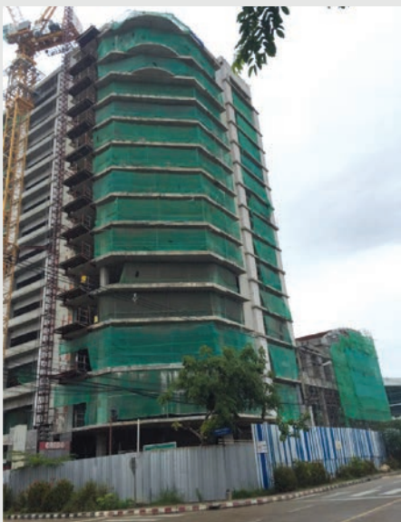
ภาพอาคารศูนย์รวมสภาวิชาชีพ และราชวิทยาลัยแพทย์ 14 ชั้น ปัจจุบันกำลังก่อสร้าง
